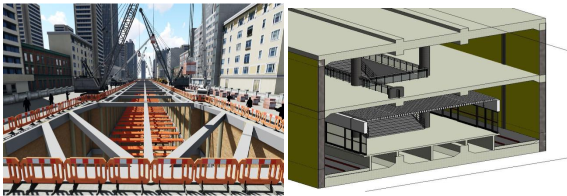
图 2 明挖法施工的地铁车站基坑与主体结构建设现场交互
